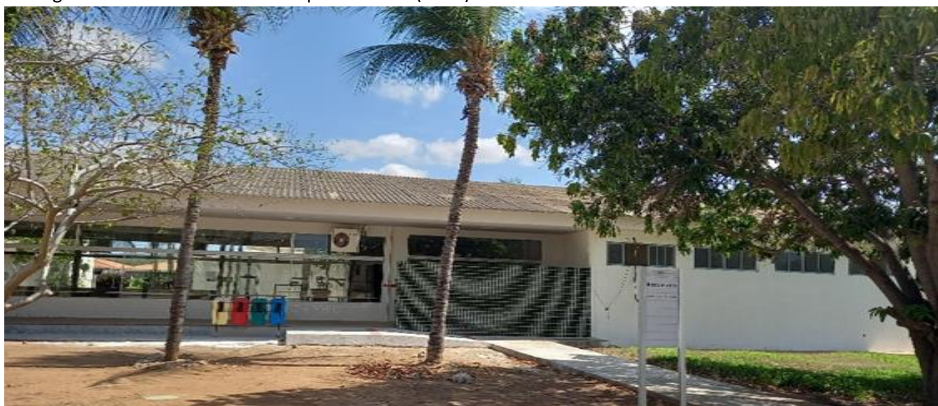
Figura 70 Refeitório reformado parte detrás (2021) – foto: Nonato
