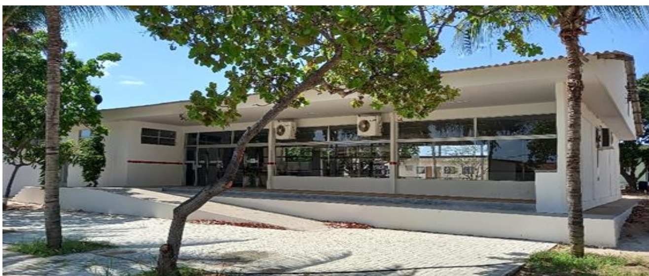
Figura 69 (2021) Refeitório estudantil reformado – foto: Nonato
