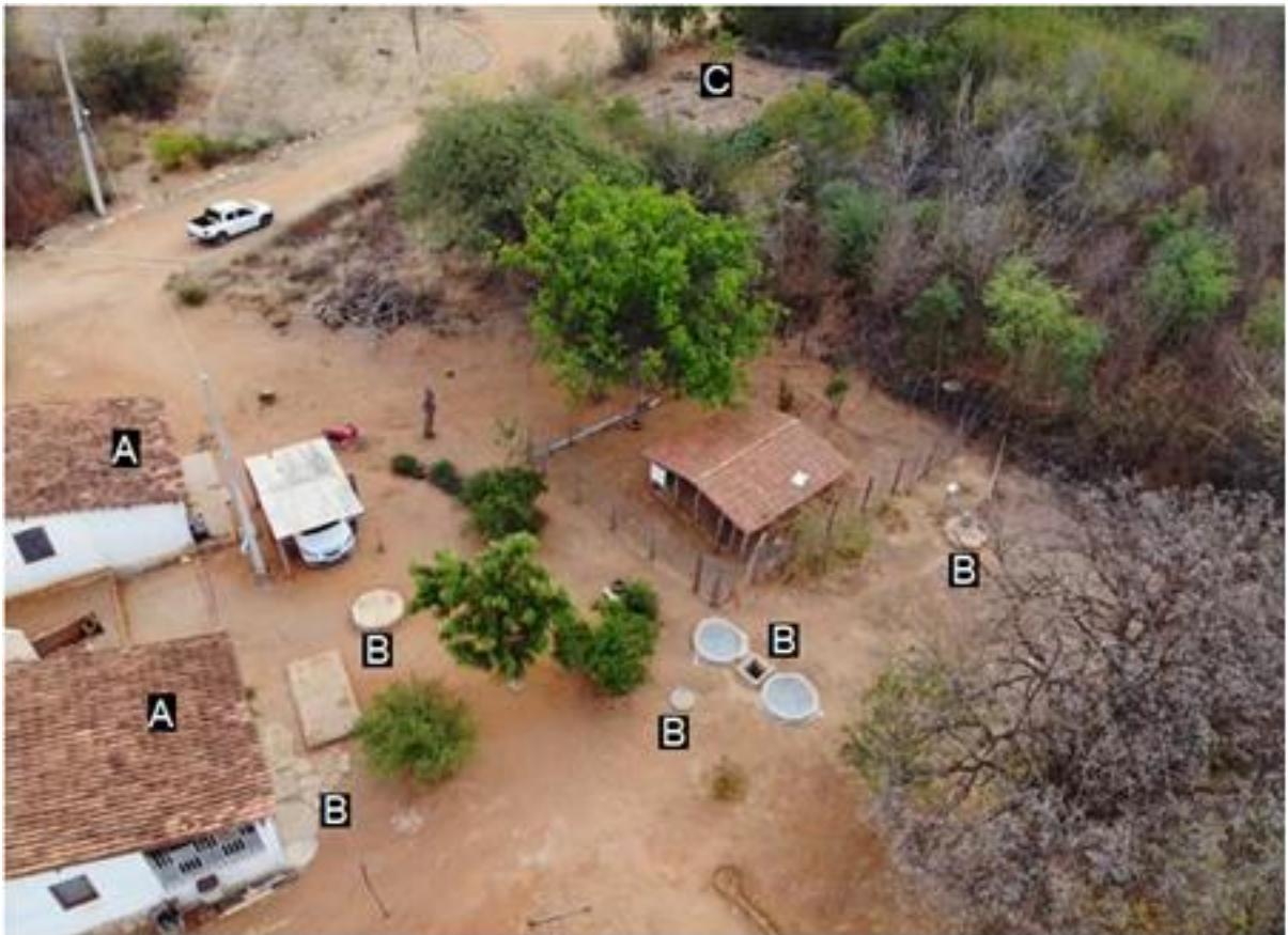
Figura 3 – Vista aérea do Centro de Formação Dom José Rodrigues – CFDJR do Instituto Regional da Pequena Agropecuária Apropriada – IRPAA em Juazeiro-BA. (A) Casas de Moradores do CFDJR; (B) localização dos componentes do sistema de tratamento; (C) área de reúso.
