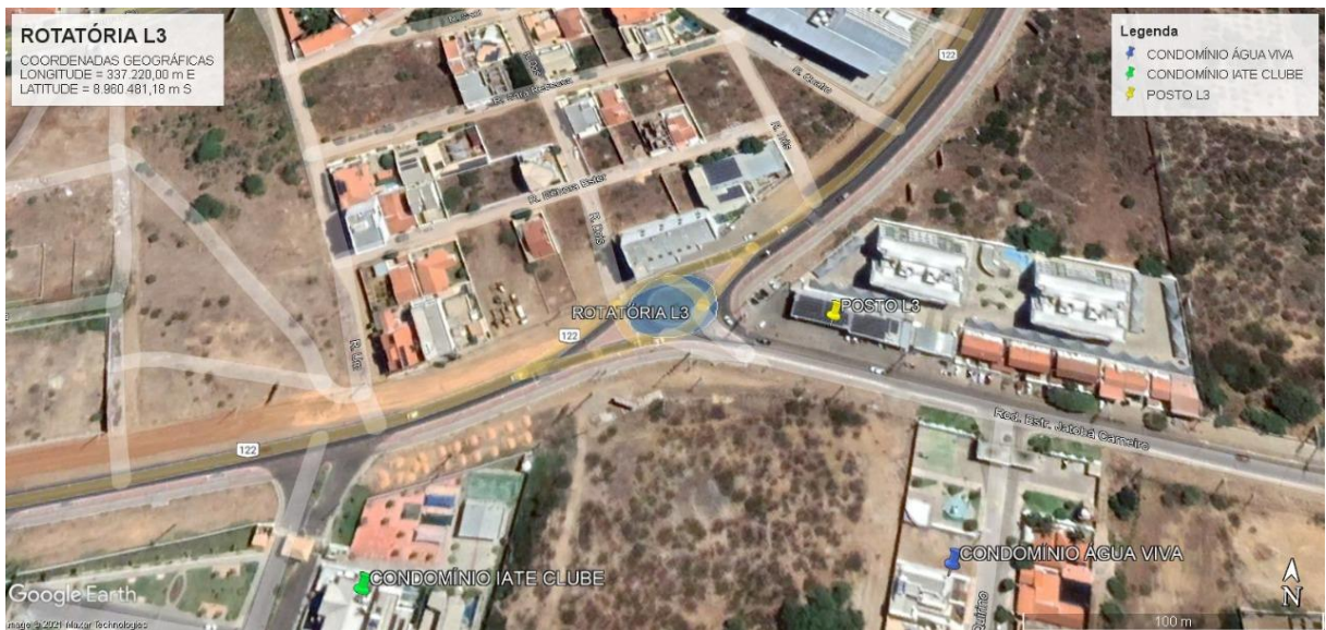
Figura 8: Vista aérea e coordenadas geográficas da rotatória L 3, na cidade de Petrolina, PE.
