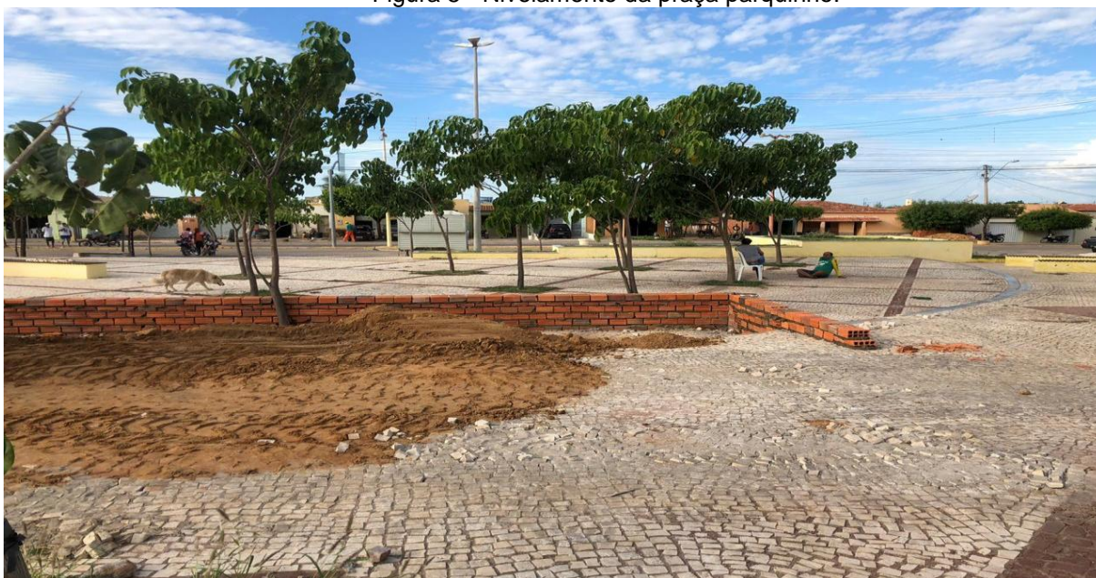
Figura 5 - Nivelamento da praça parquinho.
