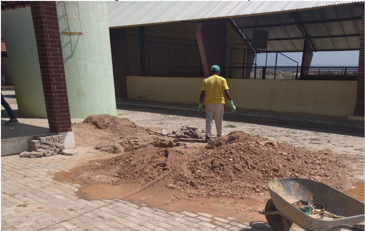
Figura 3 - Análise das caixas da tubulação
