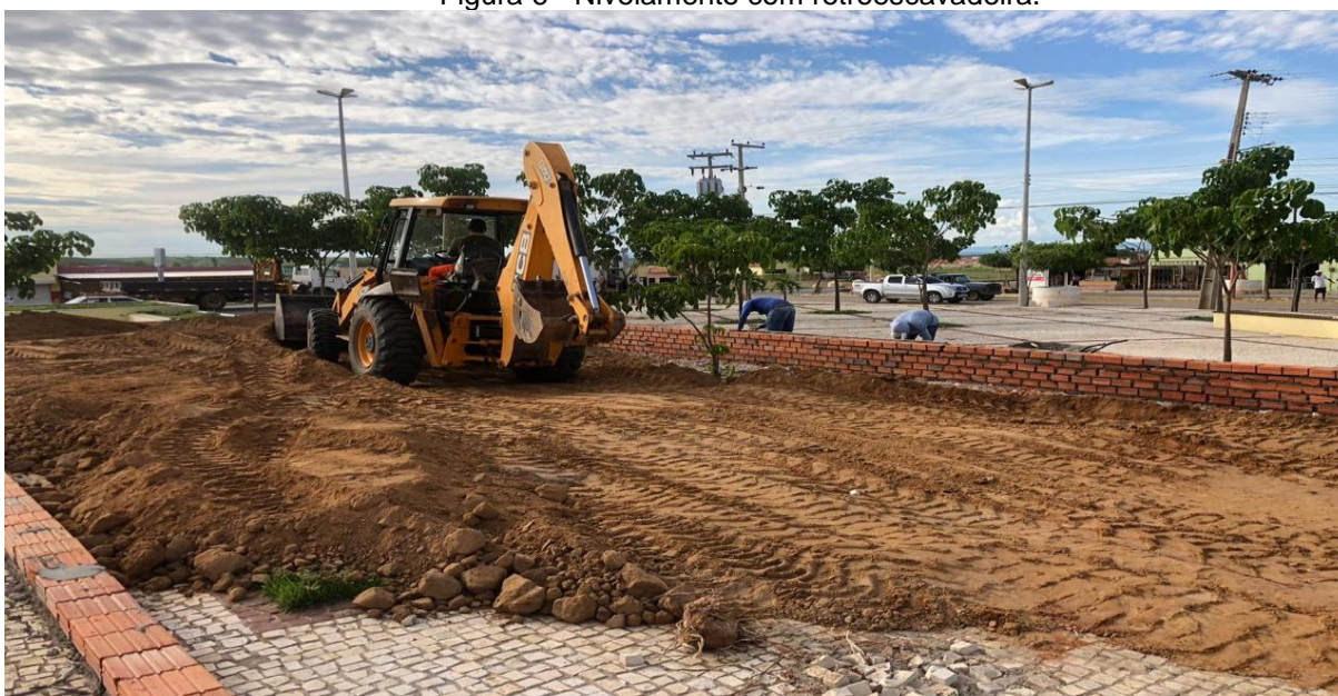
Figura 6 - Nivelamento com retroescavadeira.
