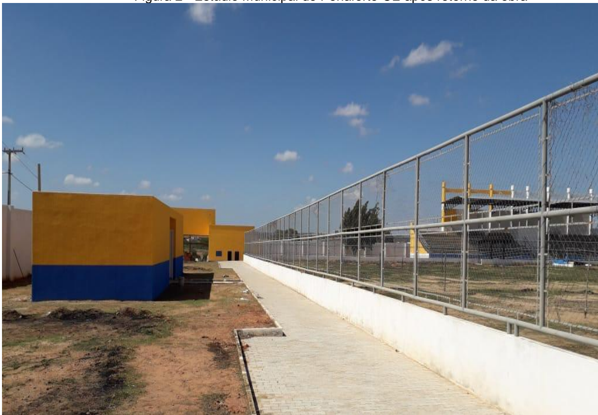
Figura 2 - Estádio Municipal de Penaforte-CE após retorno da obra
