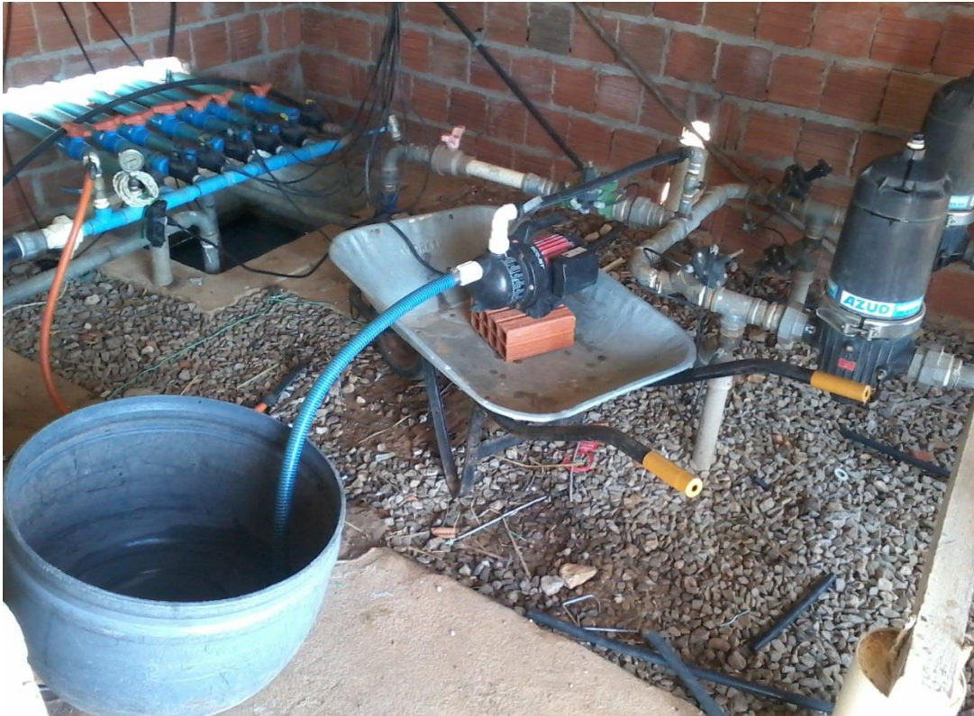
Figura 2: Solução sendo injetada no sistema de irrigação. Foto: SILVA, J.A. (2016).
