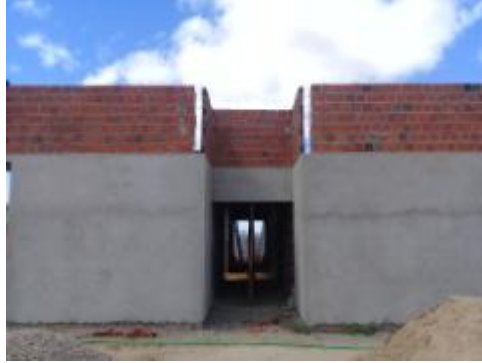
Figura 4: levantamento de alvenaria
