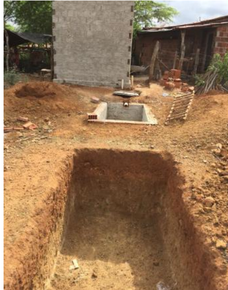
Figura 2: Serviços iniciais de uma obra
