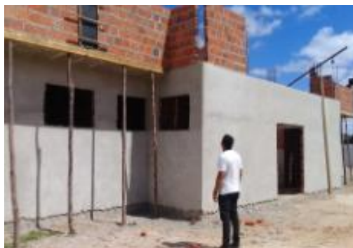
Figura 3: Fiscalização das etapas construídas
