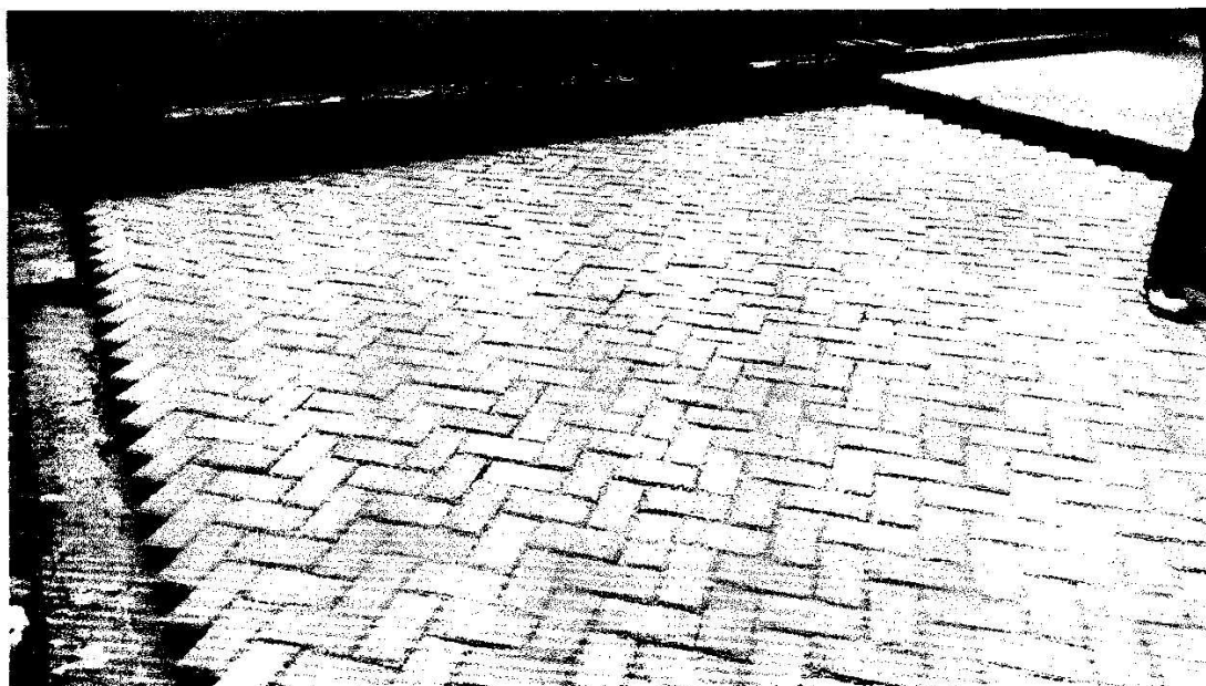
Figura-6 Piso de bloco intertravado irregular da creche Cohab
