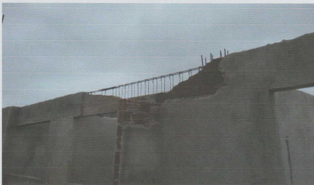
Figura 3.1 – Construção da creche do Planalto
