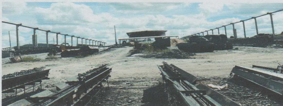
Figura 3 – Campo de concretagem Fonte: arquivo do Autor
