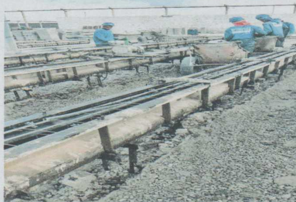
Figura 4 – Lançamento do concreto nas fôrmas Fonte: arquivo do Autor
