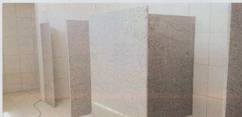
Figura 16 – Divisórias de granito nos sanitários. Fonte: Vinicius Gonçalves
