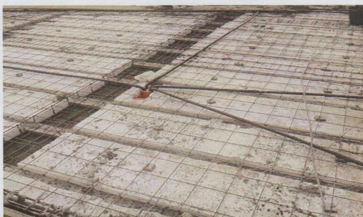
Figura 09 – Ferragem sobre espaçadores de 2cm. Fonte: Vinicius Gonçalves
