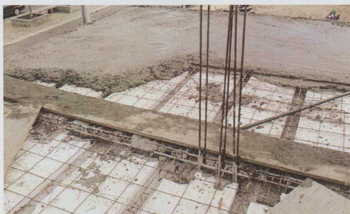
Figura 10 – Concretagem com camada de 8cm. Fonte: Vinicius Gonçalves
