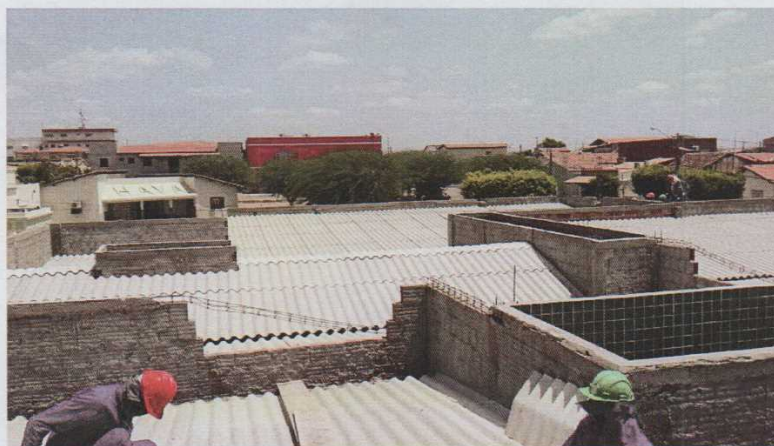
Figura 17 – Telha de fibrocimento. Fonte: Vinicius Gonçalves
