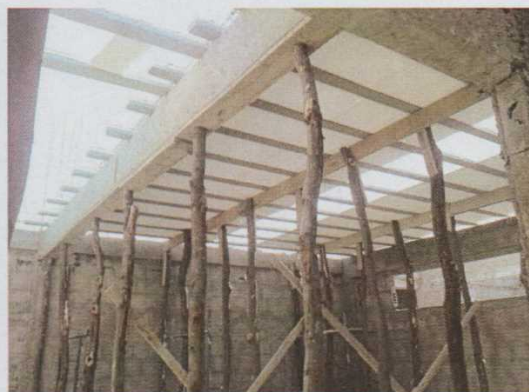
Figura 13 – Escoramento de madeira.
