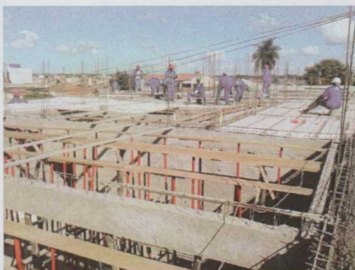
Figura 12 – Escoramento metálico.
