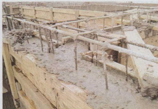
Figura 05 – Concreto depois de vibrado. Fonte: Vinicius Gonçalves
