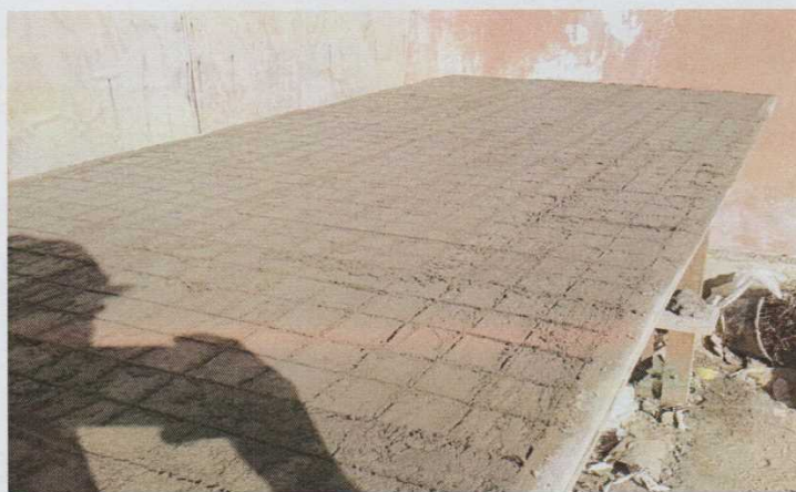
Figura 08 – Espaçadores feito na obra. Fonte: Vinicius Gonçalves
