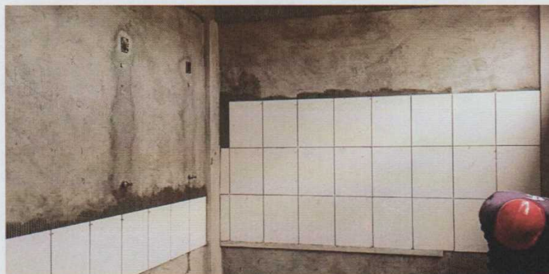
Figura 21 – Emboço interno. Fonte: Vinicius Gonçalves
