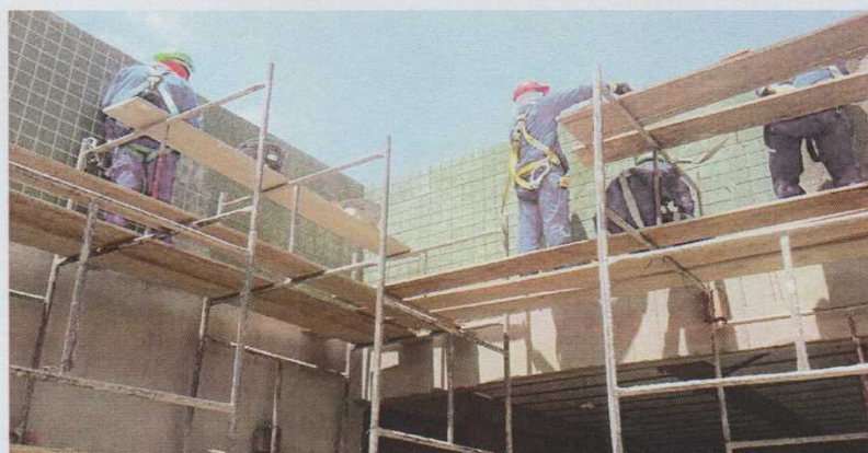
Figura 22 – Emboço externo. Fonte: Vinicius Gonçalves
