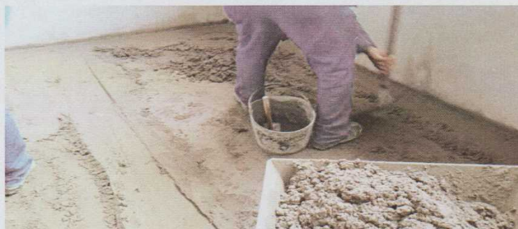
Figura 23 – Aplicação da massa no piso. Fonte: Vinicius Gonçalves
