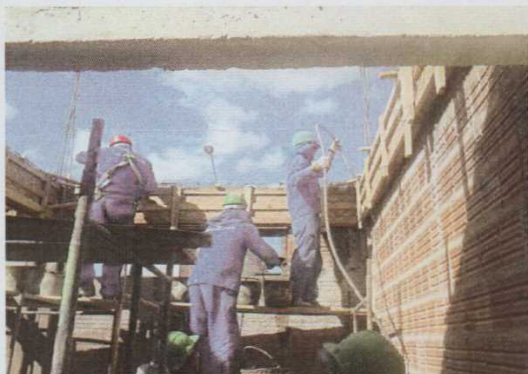
Figura 04 – Preenchimento e a vibração do concreto. Fonte: Vinicius Gonçalves
