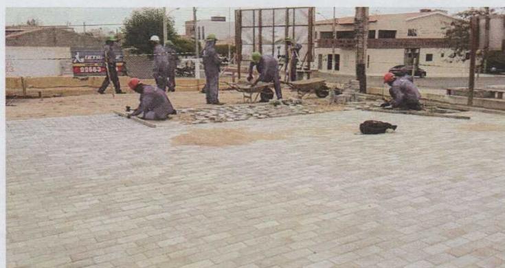
Figura 24 – Pavimentação do piso externo com intertravado de media resistência.
