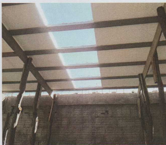
Figura 07 – EPS intercalados na Treliças
