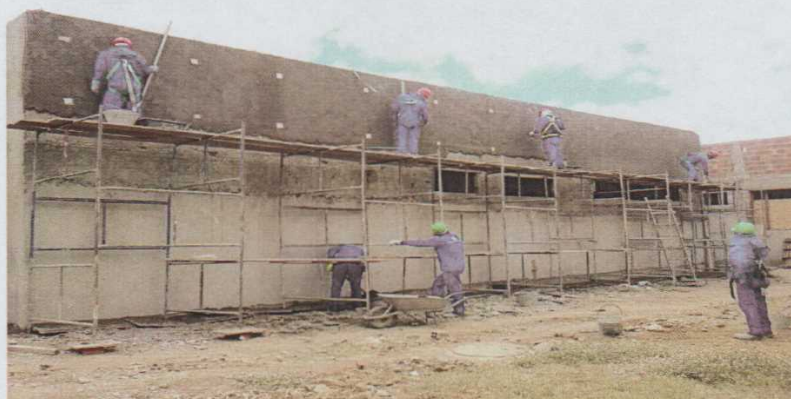
Figura 20 – Execução do reboco sobre a alvenaria chapiscada. Fonte: Vinicius Gonçalves
