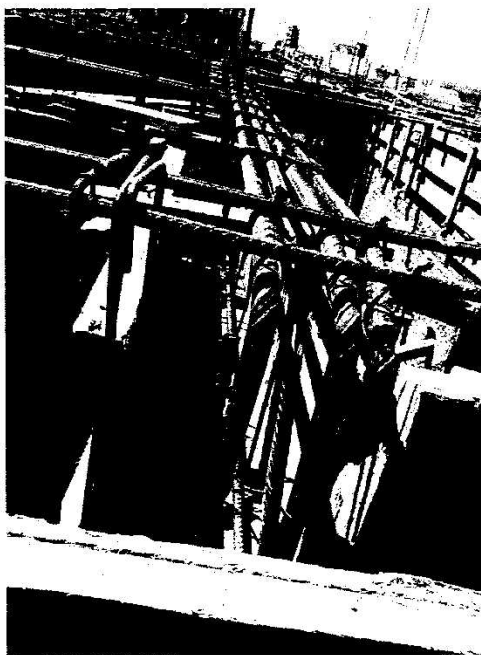
Figura 14 – Ferragem utilizada nas vigas da edificação. Fonte: Vinicius Gonçalves
