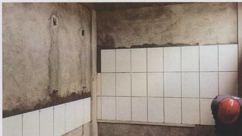
Figura 23 – Revestimento cerâmico interno após camada de emboço. Fonte: Vinicius Gonçalves
