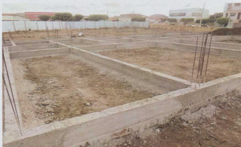
Figura 03 – Vigas baldrame Fonte: Vinicius Gonçalves
