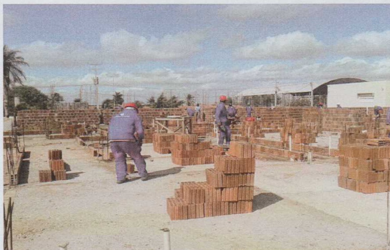
Figura 14 – Elevação da alvenaria. Fonte: Vinicius Gonçalves
