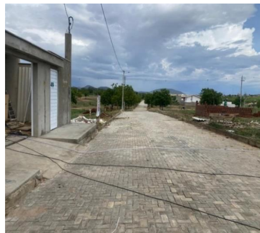
Figura 13: Pavimentação do loteamento da Construtora B.
