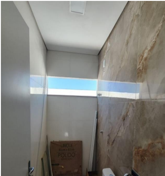
Figura 18: Banheiro Construtora A.
