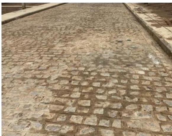
Figura 15: Pavimentação do Residencial da Construtora C.
