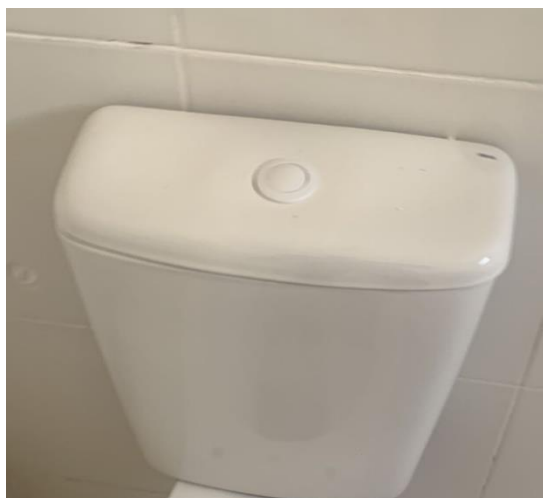
Figura 25: Descarga Construtora C.
