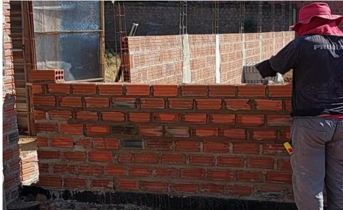
Figura 5: Assentamento de blocos cerâmicos.
