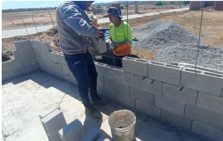
Figura 8: Assentamento de alvenaria estrutural.
