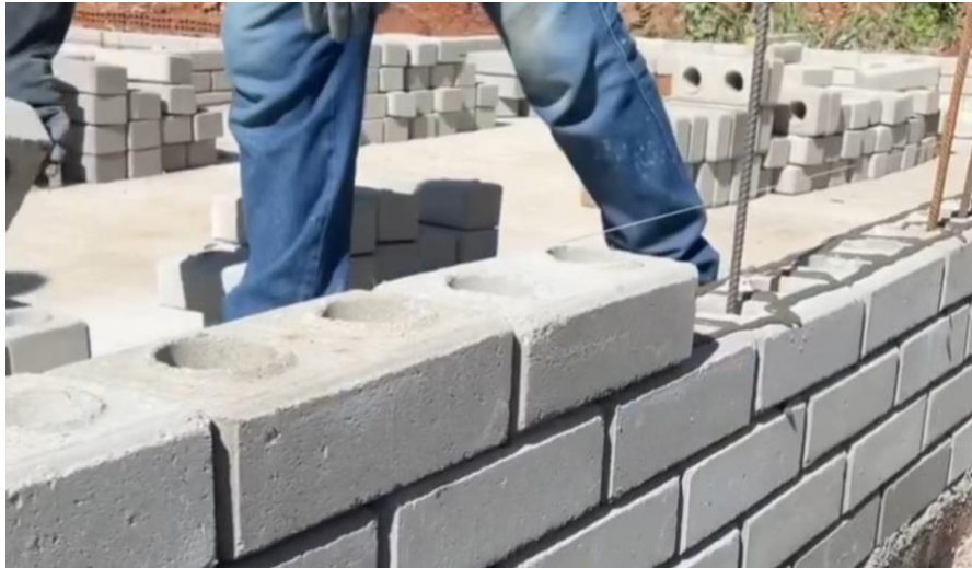
Figura 6: Assentamento de tijolo de solo-cimento.
