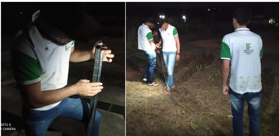
Figura 16 - Marcação de curvas de nível utilizando o nível de mangueira
