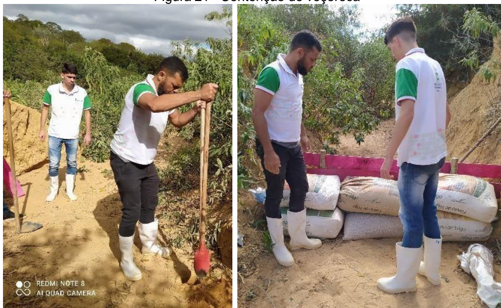
Figura 21 - Contenção de voçoroca
